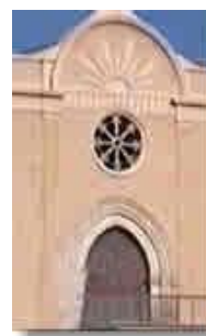
portale minore con arco a tutto sesto in mattoni rossi, poggiante su piedritti
